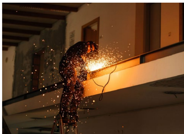
Die Innenräume samt Geländer wurden renoviert.
